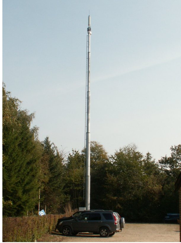
Rørmast - 32 m. Én operatør.
